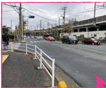
▲ 4か所の角に、しっかりとした防護柵を設置
